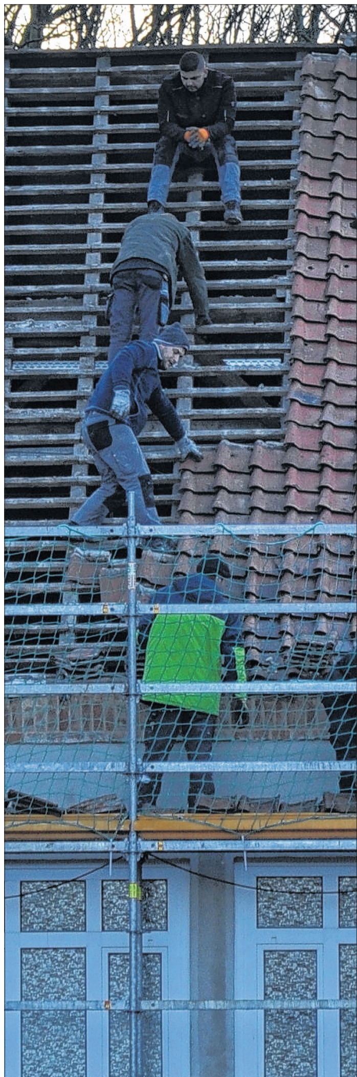
Dachdecker entblößen derzeit abschnittsweise den Dachstuhl des Gebäudekomplexes der Diesterweg-Grundschule, untersuchen das Bauwerk auf Schäden und decken ihn neu ein. Fotos (3): Jörg Endries
