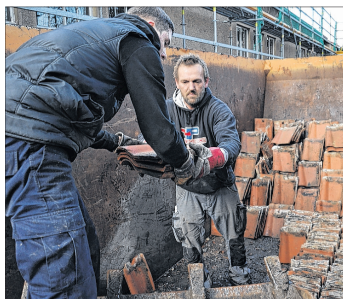
Gut sortiert sollen die nicht beschädigten Dachziegel bei Sanierungsvorhaben in der Altstadt wieder verwendet werden.
