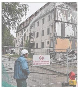
Ein Bagger schafft in der Ochsenkopfsstraße 5-8 ein Wohnbaugenossenschaft Halberstadt (WGH) reißt. Der Abriss schafft Platz für den Neubau.
