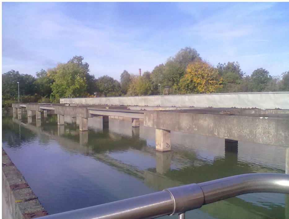
Abbildung 10: Aufbau auf stillgelegten Becken der Kläranlage Halberstadt (Foto: U. Urban)
